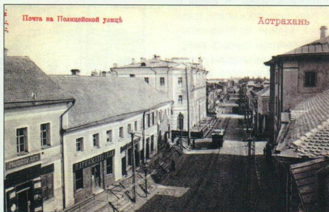
Вид на почтовую контору в начале XX в.
